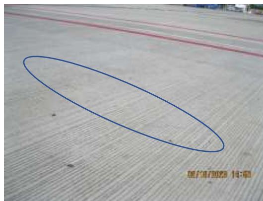
Foto 43. Fisura longitudinal
