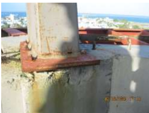
Fotos 29 a 34. Hierros a la vista en estructuras, con un grado de oxidación
