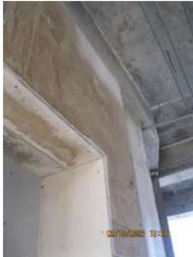
Fotos 11 y 12 Instalación de superboard – se observa efecto de humedad.
