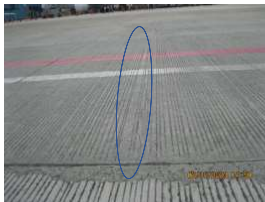
Foto 47. Fisura transversal
