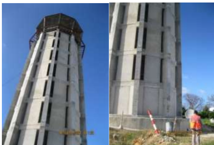
Fotos 1 y 2 Estado actual de Torre de Control
