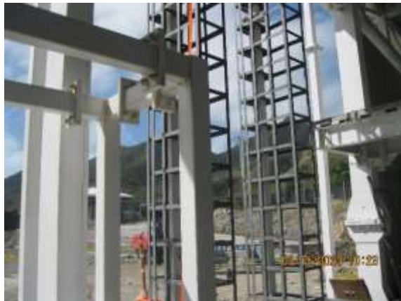
Fotos 78 a 81. Inicio de proceso de instalación de subestructura para superboard
