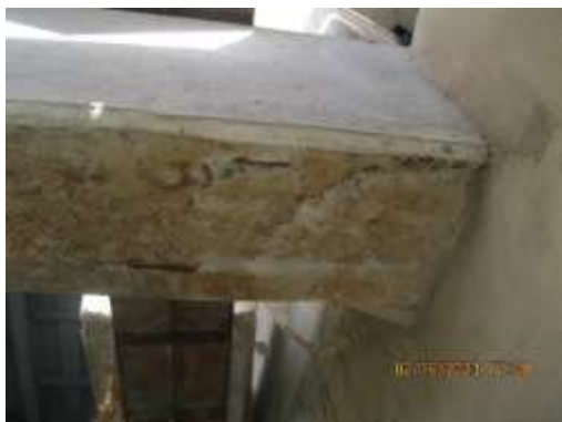
Fotos 29 a 34. Hierros a la vista en estructuras, con un grado de oxidación
