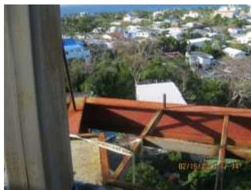
Fotos 29 a 34. Hierros a la vista en estructuras, con un grado de oxidación
