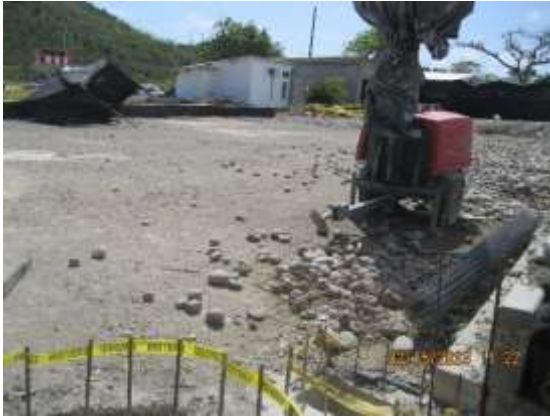
Foto 90 y 91. Zona de parqueo. Pendiente terminación y que quedaría con pozos sobresaliendo el nivel del afirmado
