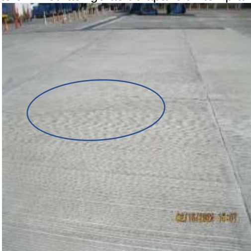
Foto 54. Fisura de esquina,
