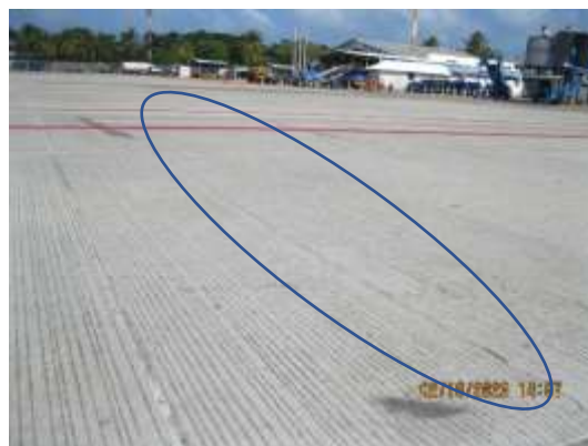
Foto 45. Fisura transversal
