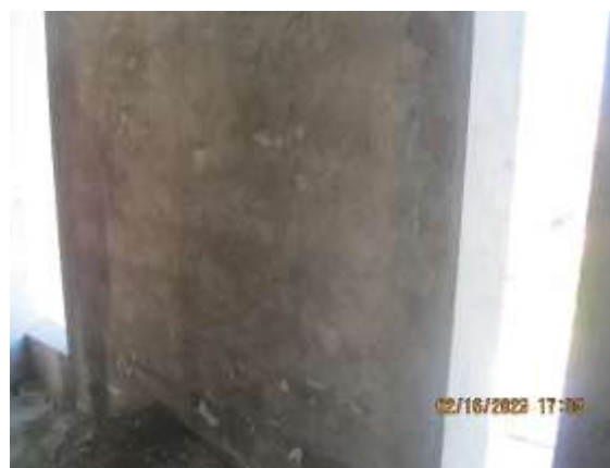
Foto 19 a 22. Afloramiento de patologías relacionadas con el ambiente de salinidad – Alcalinidad, carbonatación, humedad en estructuras de concreto
