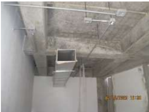
Foto 13 y 14. Instalaciones eléctricas y ducto para sistema de ventilación. Se evidencia oxidación en las varillas soporte de las instalaciones
