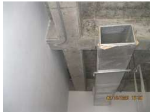
Foto 13 y 14. Instalaciones eléctricas y ducto para sistema de ventilación. Se evidencia oxidación en las varillas soporte de las instalaciones
