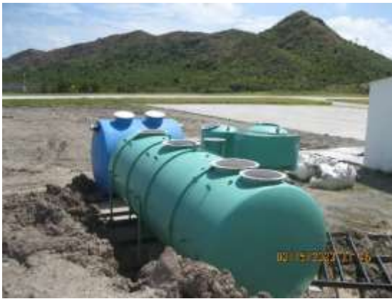
Fotos 92 y 93. PTAR, sin instalar y zona de manejo sin adecuar
