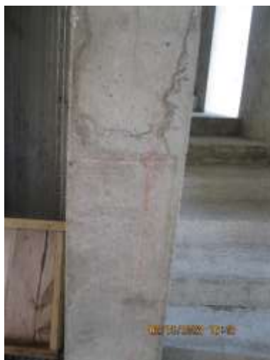
Foto 17 y 18. Afloramiento de patologías relacionadas con el ambiente de salinidad
