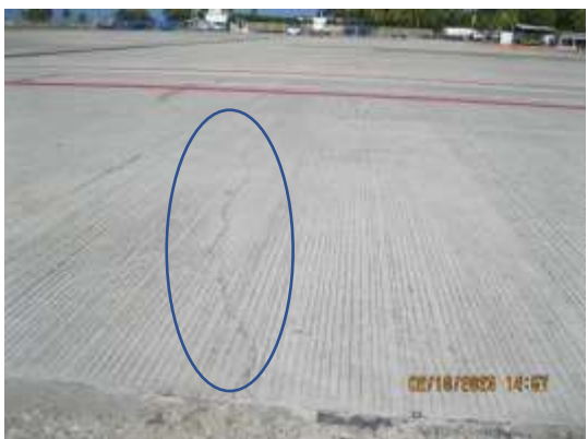
Foto 44. Fisura transversal
