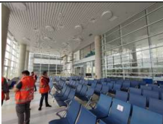
30. Uso andamios para arreglos techo.
