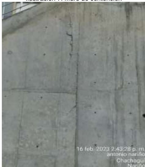
Ilustración 7: Muro de contención
