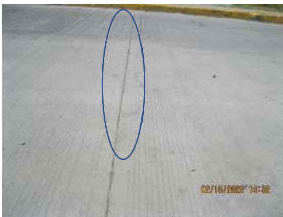
Foto 41. Fisuras transversales
