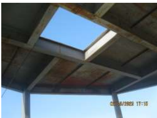
Fotos 35 y 36. Oxidación en estructuras metálicas (fanal)
