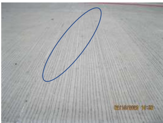
Foto 42. Fisura transversal
