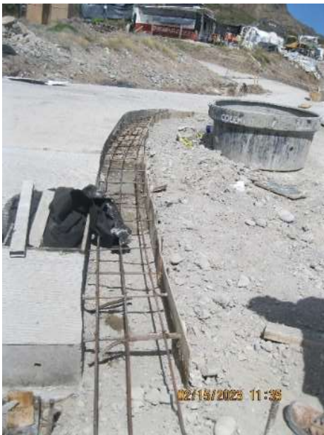
Foto 88. Construcción de viga de confinamiento.
