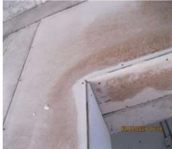
Fotos 11 y 12 Instalación de superboard – se observa efecto de humedad.
