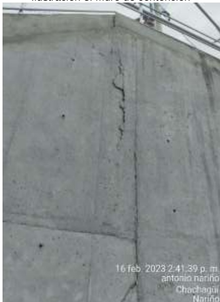
Ilustración 5: Muro de contención
