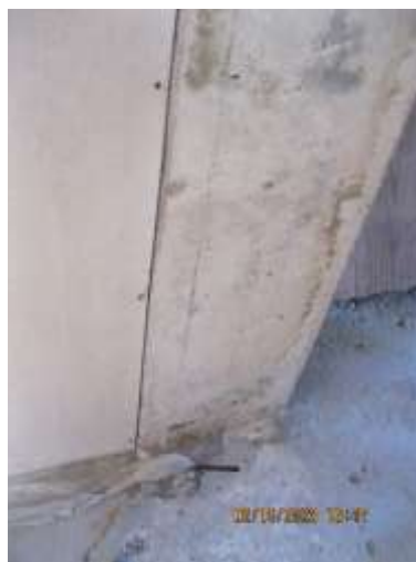
Foto 17 y 18. Afloramiento de patologías relacionadas con el ambiente de salinidad
