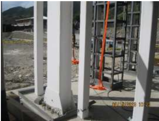
Fotos 78 a 81. Inicio de proceso de instalación de subestructura para superboard
