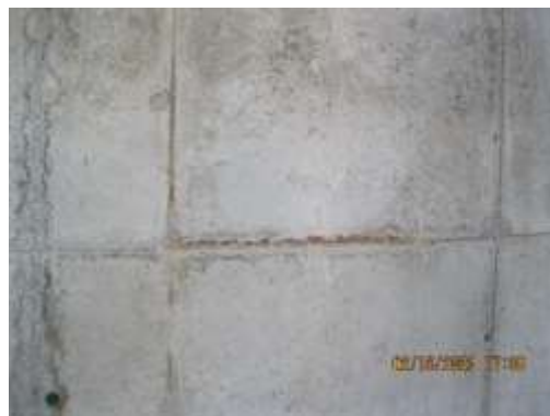
Fotos 29 a 34. Hierros a la vista en estructuras, con un grado de oxidación
