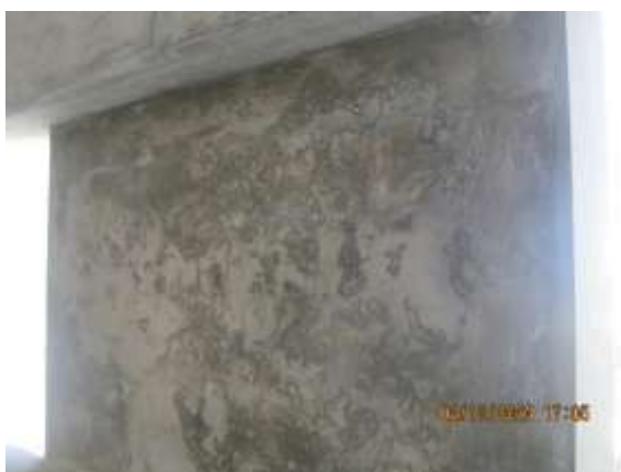
Foto 19 a 22. Afloramiento de patologías relacionadas con el ambiente de salinidad – Alcalinidad, carbonatación, humedad en estructuras de concreto
