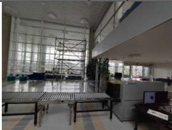
33. Uso andamio arreglo ventaneria.
